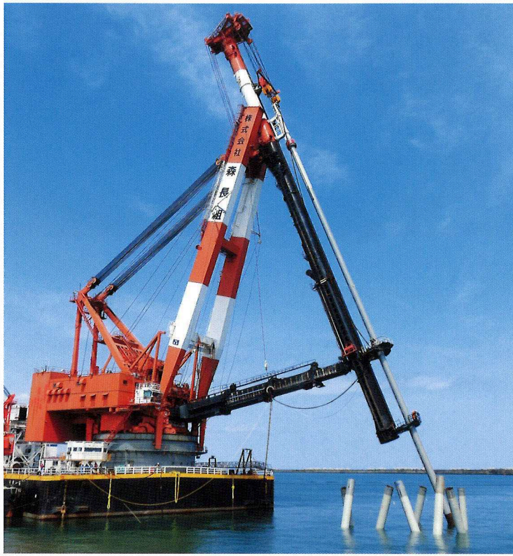
S-280 による鋼管杭打設 ( \phi 700\text{mm} , L = 79.3\text{m} , \theta = 20^\circ )
