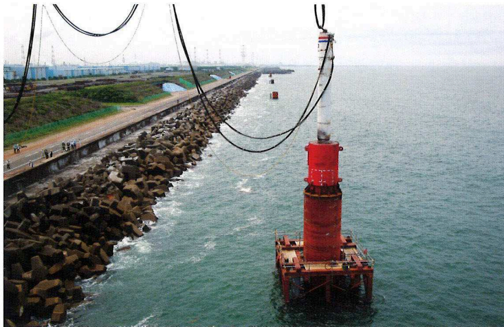
S-500 による鋼管杭打設 ( \phi 3500\text{mm} , t 44\text{mm} , L = 24.5\text{m} )
